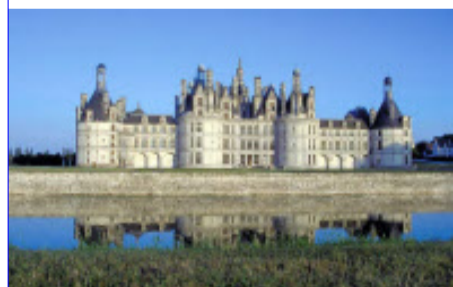
Château Chambord – eines der prächtigsten Loire-Schlösser. ATOUT FRANCE
